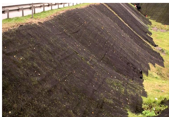
Рисунок 1 – Применение противоэрозионного материала геомата марки Энкамат 7225
