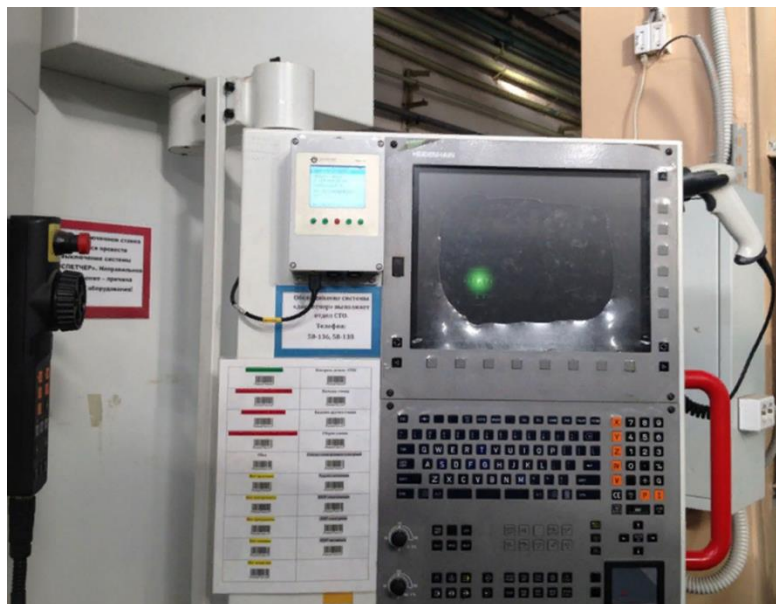
Рисунок 3 – Терминал-регистратор ТВВ10 смонтированный на стойке ЧПУ Heidenhain
